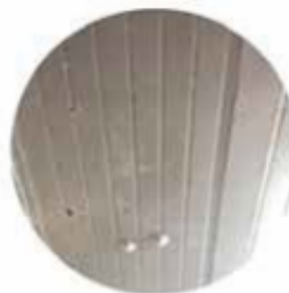
Techo de cuarto frío 8 semana después de instalar ChillSafe
